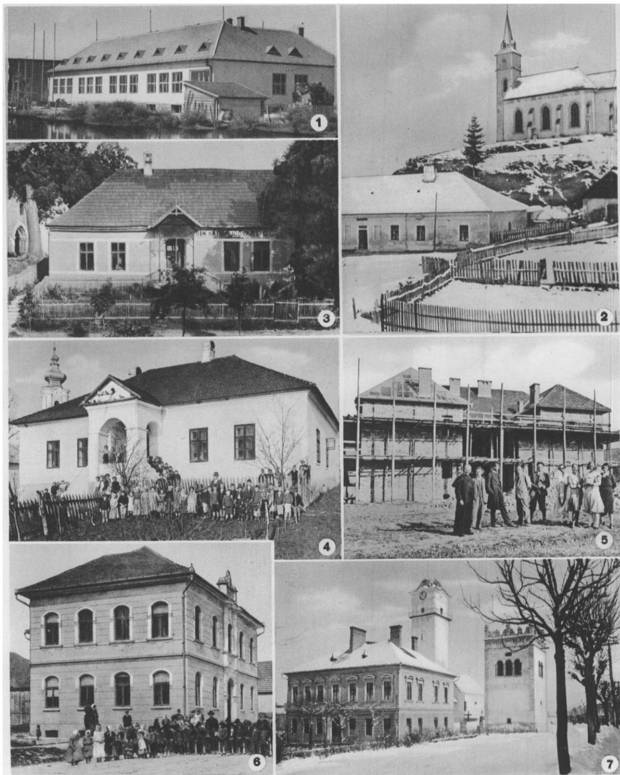
UKÁŽKY BUDOV R. KAT. ĽUDOVÝCH ŠKÔL Z DIECÉZY SPIŠSKEJ: 1. Poprad, nová škola. 2. Veľký Hnilec. 3. Toporec. 4. Rychnava. 5. Liptovská Teplička, stavba školy. 6. Líšková. 7. Poprad, stará škola.
