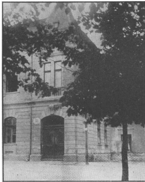
R. k. ľud. a mešt. dievč. škola v Ružomberku Budova školy — vchod
