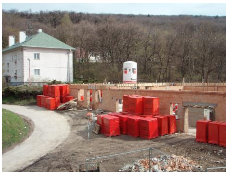
Priebeh výstavby nového lôžkového pneumologického pavilónu (apríl 2008)
