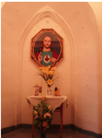
Pohľad na zdvojenú niku po gotickom okne. Väčšia je v obvodovom murive, menšia zo zamurovanej kamennej špalety okna. Hore je ukončená lomeným hrotovým uzáverom s lunetovým oblúčikom.
